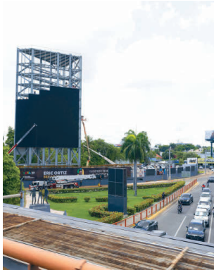
Los trabajos están avanza- dos.
